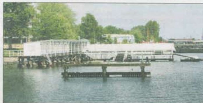
Im Spätherbst soll die alte Seebadeanstalt, die in diesem Sommer noch genutzt werden kann, abgebaut werden, um Platz für die neue zu schaffen.
